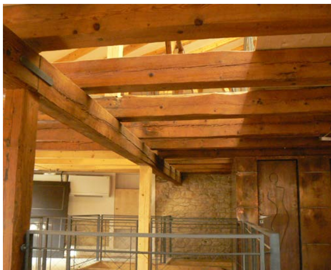
Realizace protipožárního nátěru FLAMGARD TRANSPARENT .
