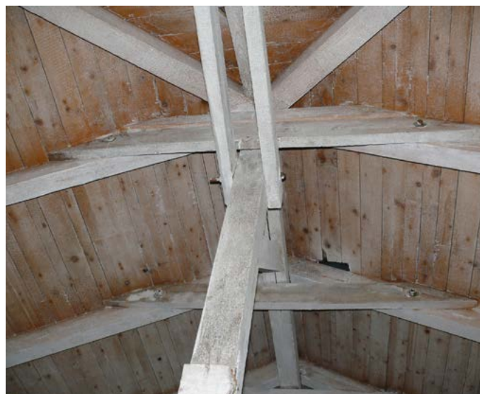
Realizace protipožárního nátěru FLAMGARD .
